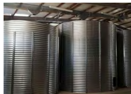
Figure 4 : Silo à céréales de la Malterie, Source : SudOuest.fr
