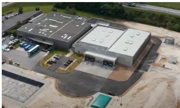
Vue aérienne du nouveau bâtiment (à droite)
